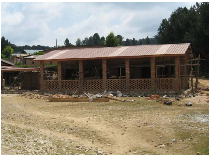
Gatare : L'ambulatorio pediatrico in via di completamento
